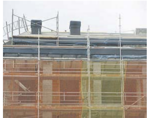
Reforma de un edificio en Ourense.
