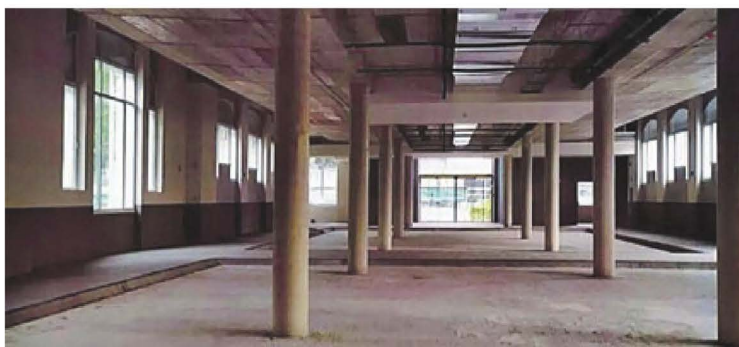
Así está hoy el interior del edificio histórico de la Plaza de Abastos.
