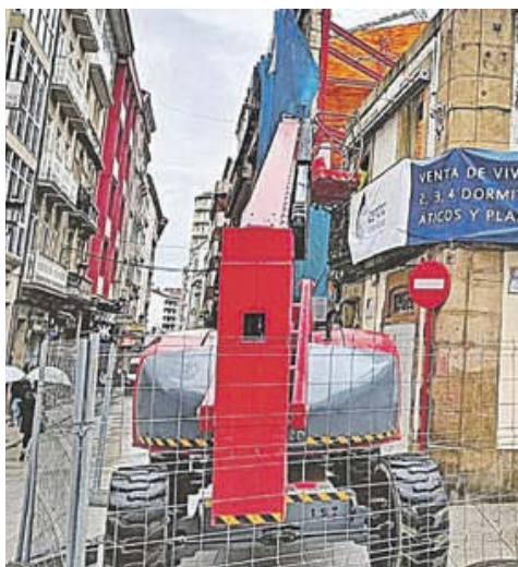
Construcción de viviendas en la calle Santo Domingo, en marzo del pasado año.
