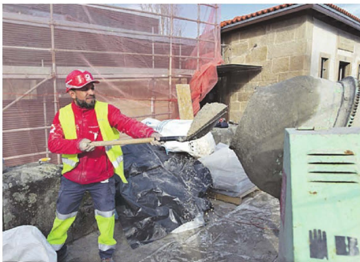
Un operario prepara cemento para una obra en el Puente Romano.
