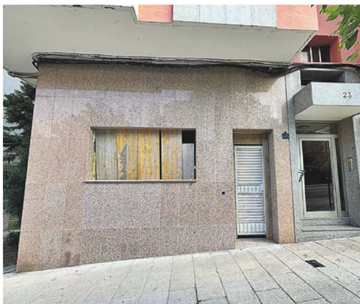
Bajo situado en la Avenida de la Universidade con la restauración casi finalizada.
